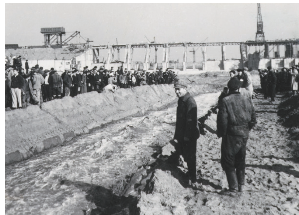
Затопление котлована на строительстве Воткинской ГЭС. 1957 г. Фотоотпечаток. ГАПК. Ф. ф-63. Оп. 63п. Д. 705. Л. 5.
