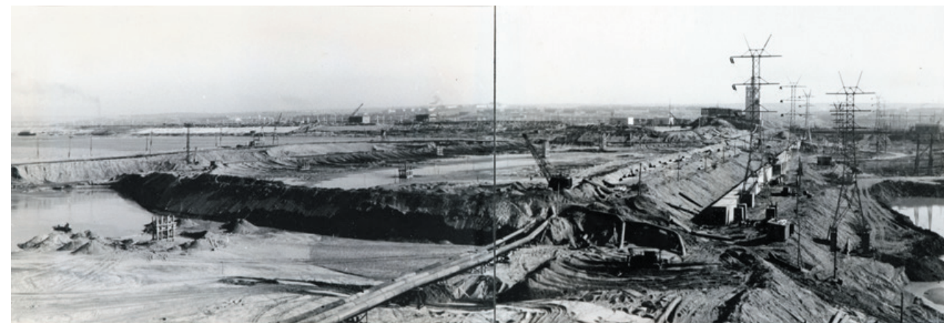
Вид со стороны левобережного устья Камской ГЭС на русловую плотину во время намыва. 1955 г. Фотоотпечаток. ГАПК. Ф. р-1516. Оп. 1. Д. 52. Л. 29.
